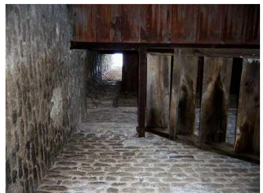
3. Interno della torre (dal basso verso l'alto)
