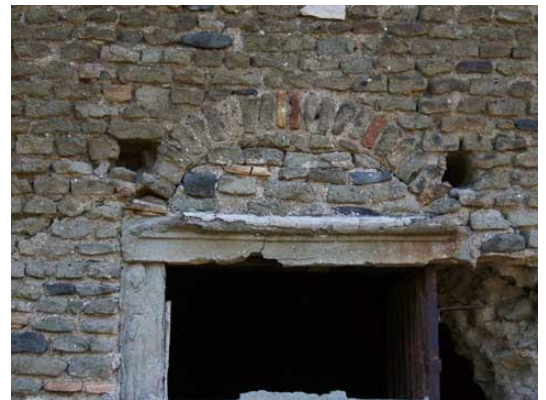
5. Archetto di scarico sopra l'ingresso al piano terreno
